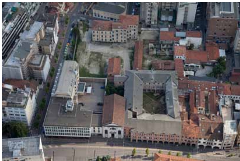
Fig. 4 - The M9 area, seen from above (© Fondazione di Venezia, foto di ORCH/orsenigo_chemollo, 2009).
